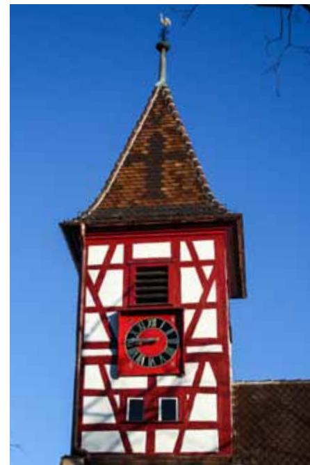
Die Fachwerkbalken erstrahlen wieder in einem warmen, leuchtenden Dunkelrot
